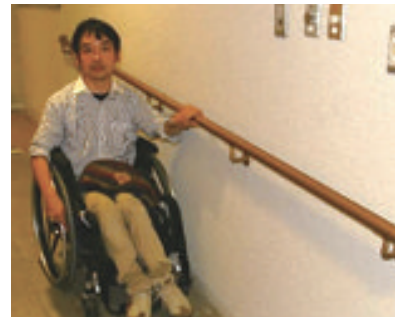
廊下に設置された手すり
