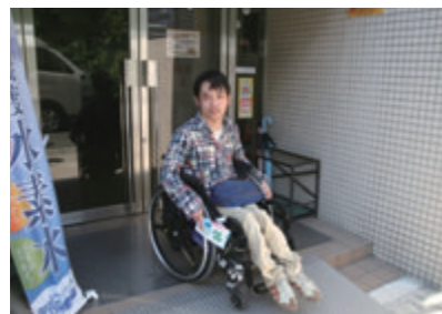
スロープ板を設置した事例
