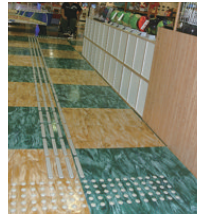
通路に敷設された視覚障害者誘導用ブロック
