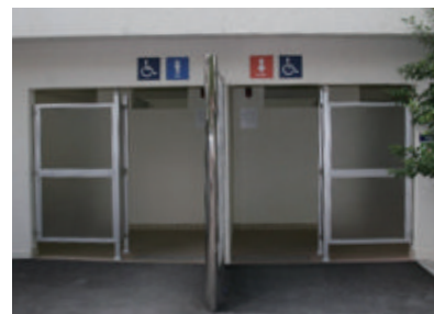
障害者対応トイレ
